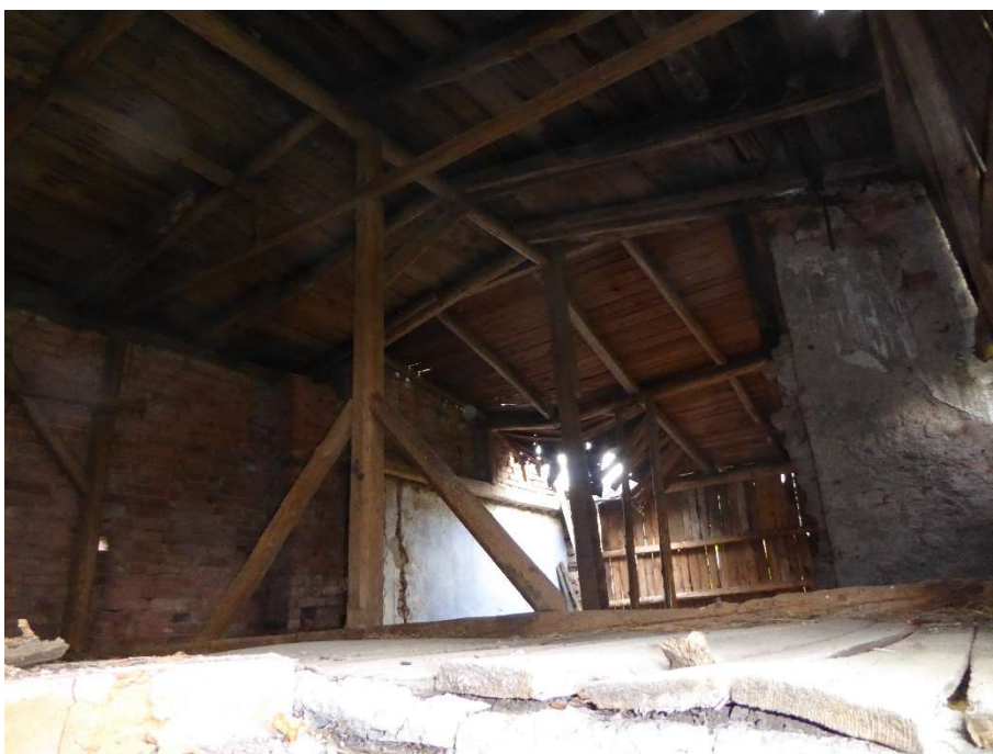
3. Budynek gospodarczy – widok wewnątrz poddasze
