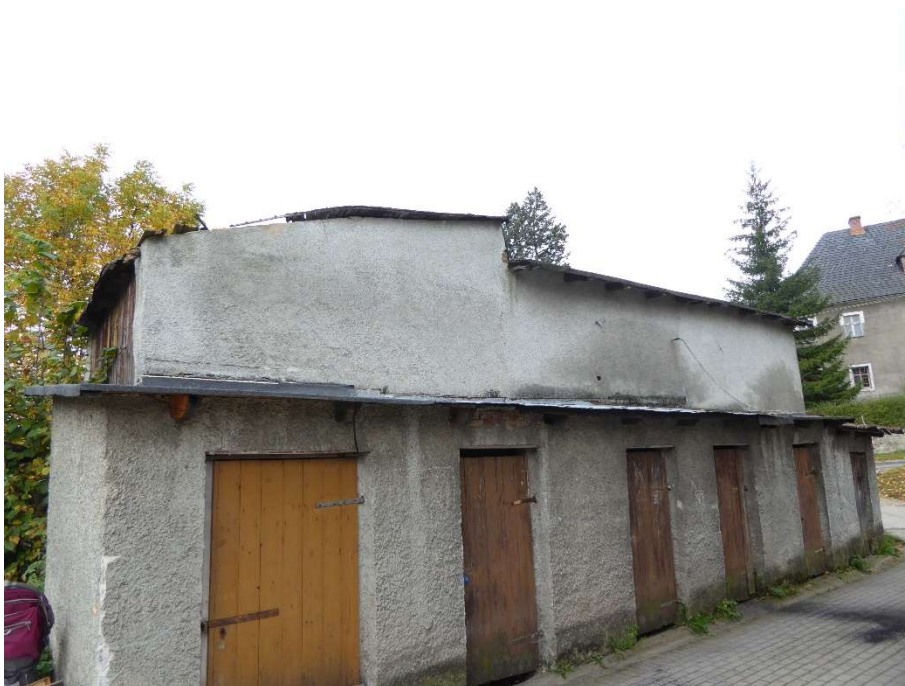
4. Budynek gospodarczy – widok na komórki przylegające od strony północnej nie przeznaczone do rozbiórki
