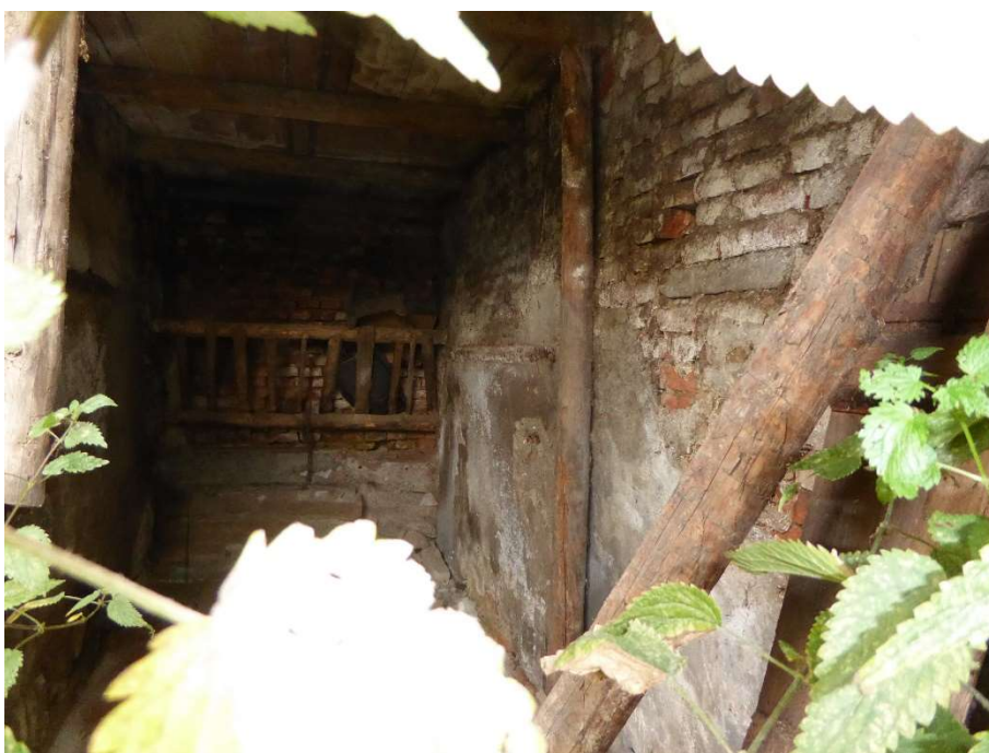
2. Budynek gospodarczy – widok wewnątrz parteru
