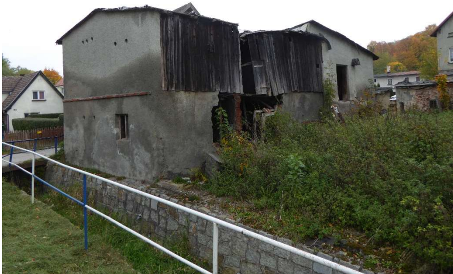
1. Budynek gospodarczy – widok na ściany południową oraz zachodnią
